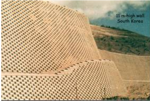
組み立て式壁面ネット用ブロックを用いた補強土壁
