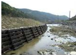
Thi công khối PE
