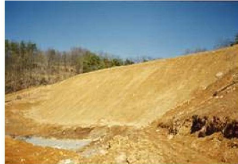
Đê đập được gia cường đã hoàn thành
