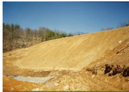
Aterro reforçado concluído
