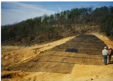
補強材の敷設状況
