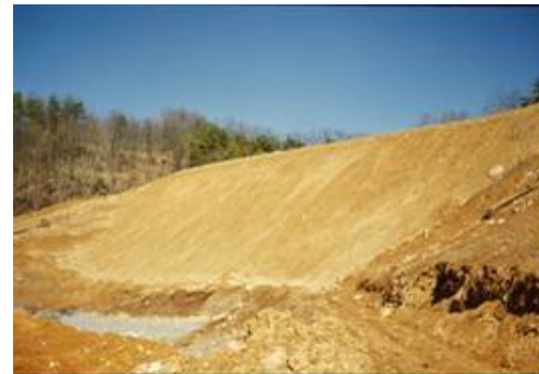
完成時の補強盛土斜面
