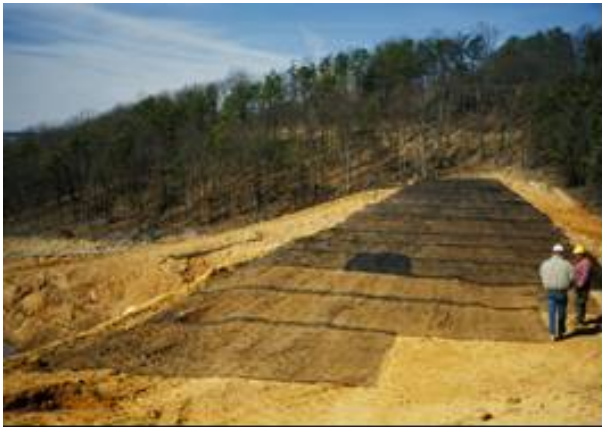
主加筋层的铺设
