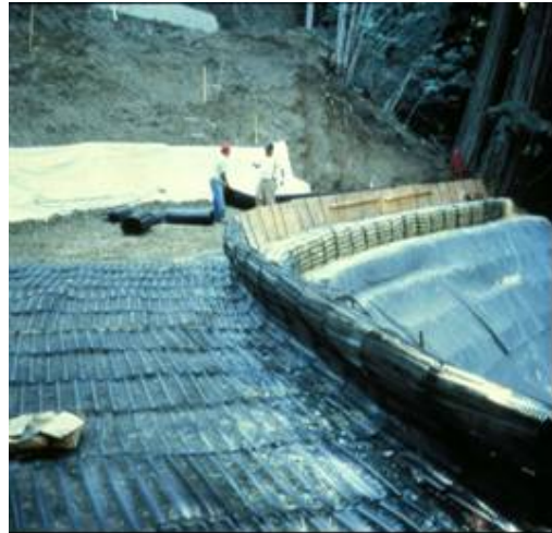
用边坡加筋结构修复边坡的实例
