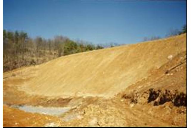
完成后的加筋堤坝
