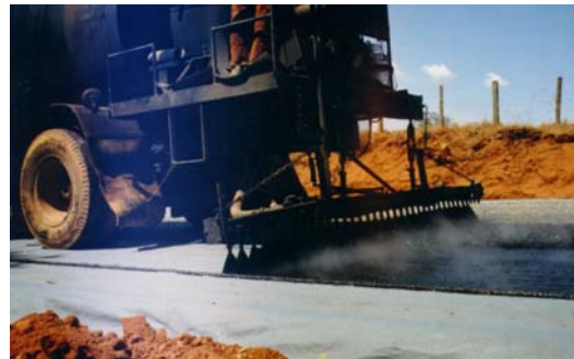
Aplicación de geosintéticos en pavimentos (**)
