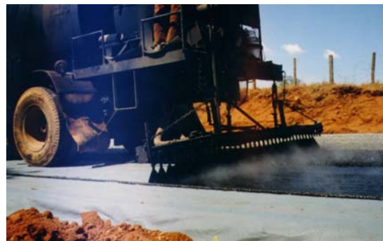
土工合成材料用于道路建造 (*)
