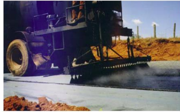
Üstyapı kaplama imalatındaki geosentetik (*)
