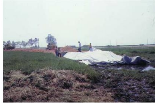
Yumuşak organik kil üzerinde takviyeli kaplamasız yol inşaatı
