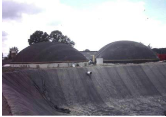
Anaerob çürütücülü atık göleti
