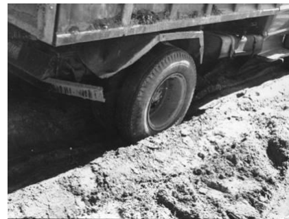
Типичный механизм разрушения неармированной грунтовой дороги
