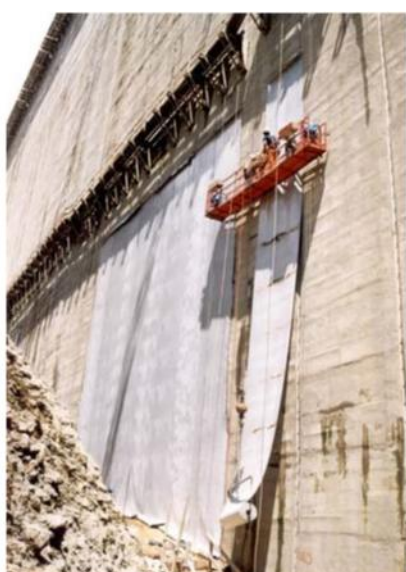
Облицовка лобовой части плотины (*)
