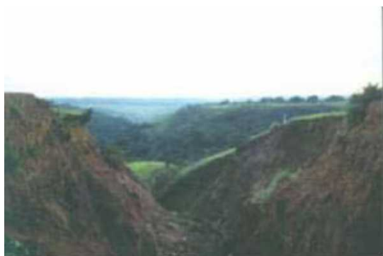
Ravina de eroziune
