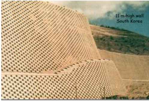
Rivestimento con elementi modulari in muratura
