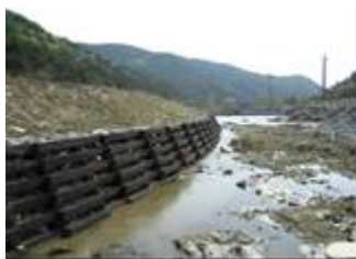
PEブロックの施工
