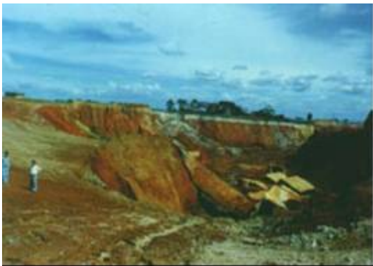
Dommages causés par l'érosion
