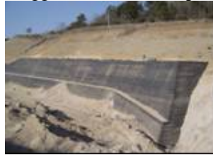
Esempi di rivestimento di facciate di opera in terra rinforzata
