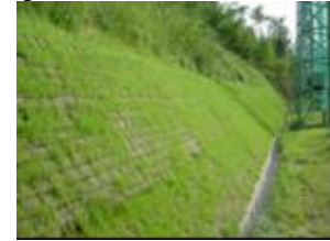
Esempi di rivestimento di facciate di opera in terra rinforzata
