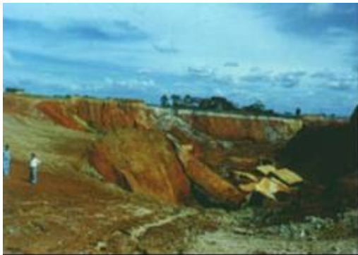
Danni causati dall'erosione
