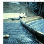
Ejemplo de talud reforzado con suelo reforzado.
