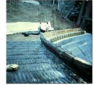
Esempio di stabilizzazione di un pendio mediante rinforzo
